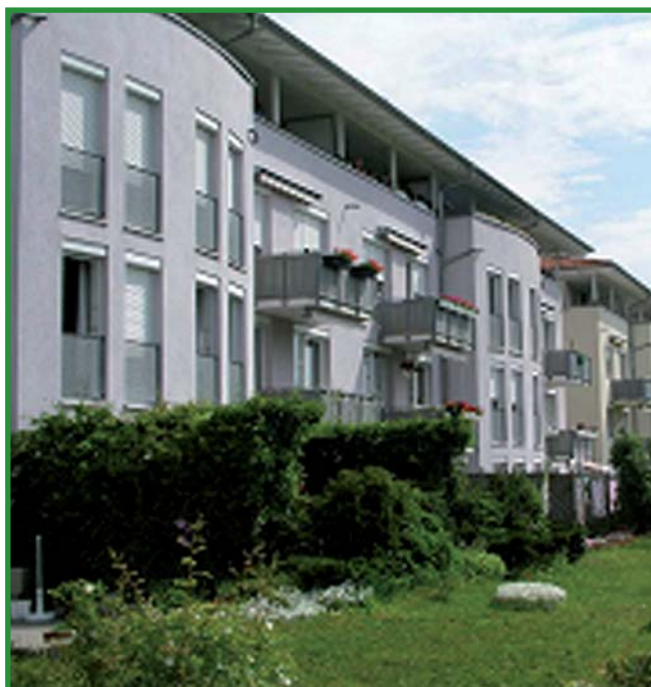
Immeubles d'appartements en copropriété
