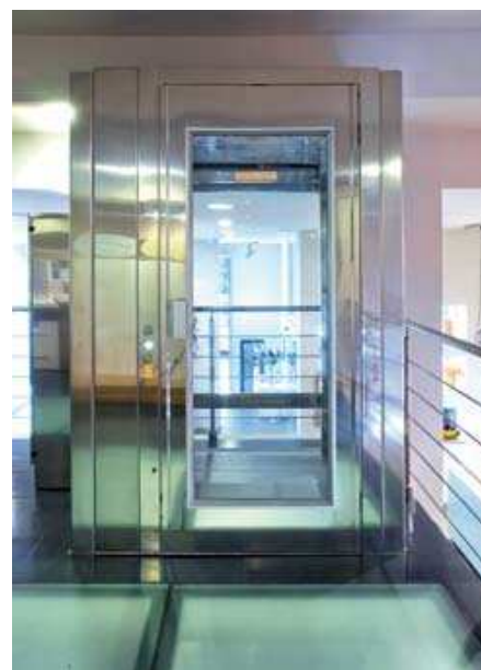
Installation avec une gaine en inox
