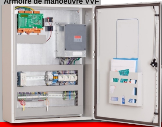
Armoire de manoeuvre VVF
